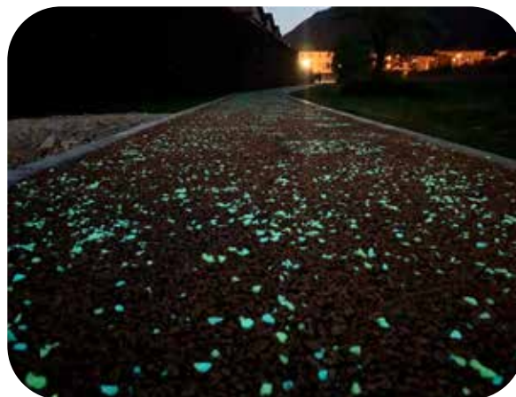
Pista ciclabile di Borgo a Mozzano (LU), pavimentazione drenante ad effetto "cielo stellato"
