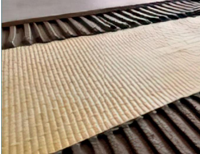
In presenza di sottofondi critici o lesionati è necessario porre molta attenzione alla posa di ceramica o pietre naturali poiché le tensioni sottostanti potrebbero trasmettersi alla pavimentazione, causando delle fessurazioni.
